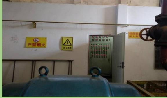
氨压缩机冷凝机组
