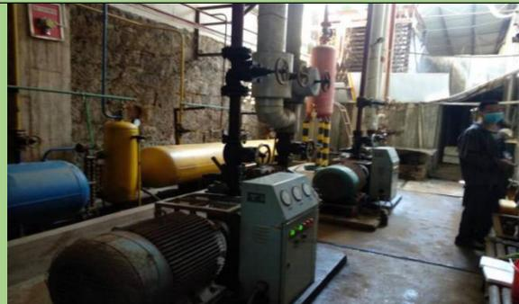
氨压缩机冷凝机组
