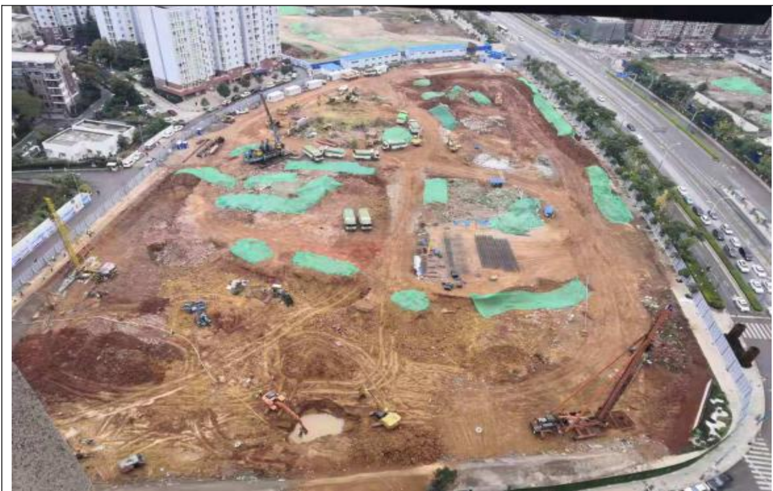
图 2.1-1 厂区采样前现状俯瞰图
